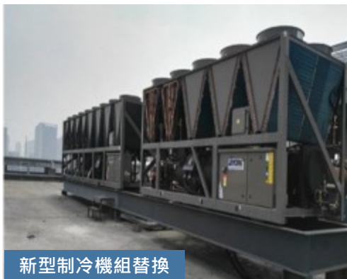
新型制冷機組替換
