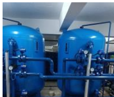
越南生產中心雨水回收處理系統
