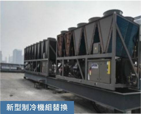
新型制冷機組替換
