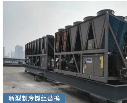
新型制冷機組替換
